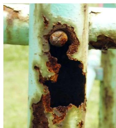
◆金属の腐食による穴
