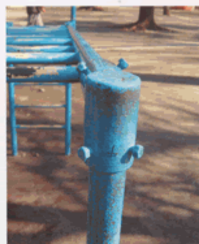
ネジの突起による引っかかり
