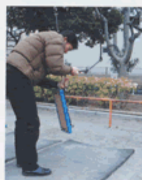
戻せるようであれば、鎖のねじれを戻しましょう。吊り席を鎖の間を過すように回してみてください。さらに、ねじれるようなら逆方向に回してみてください。
