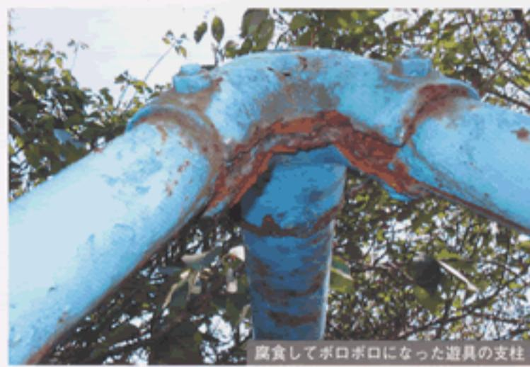
腐食してボロボロになった遊具の支柱
