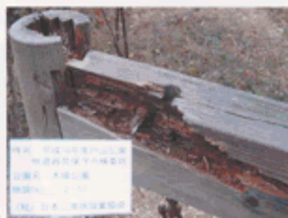
腐食した木製遊具
