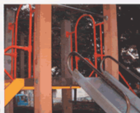
すべり台の手すりによる引っかかり
